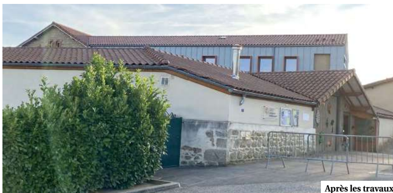
Après les travaux
