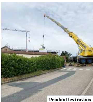
Pendant les travaux
