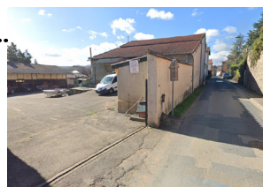
Vue sur le site de projet depuis la route du Barrage
