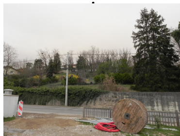
Vue sur le site de projet depuis la Route de la Vallée du Garon
