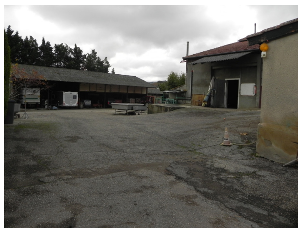
Vue sur le site de projet depuis la route du Barrage
