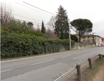
Mur à préserver
