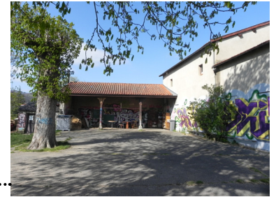
Vue sur l'ancienne école
