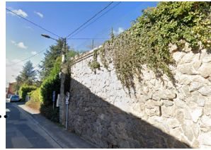
Vue sur le côté droit de la voie en direction de l'Ouest
